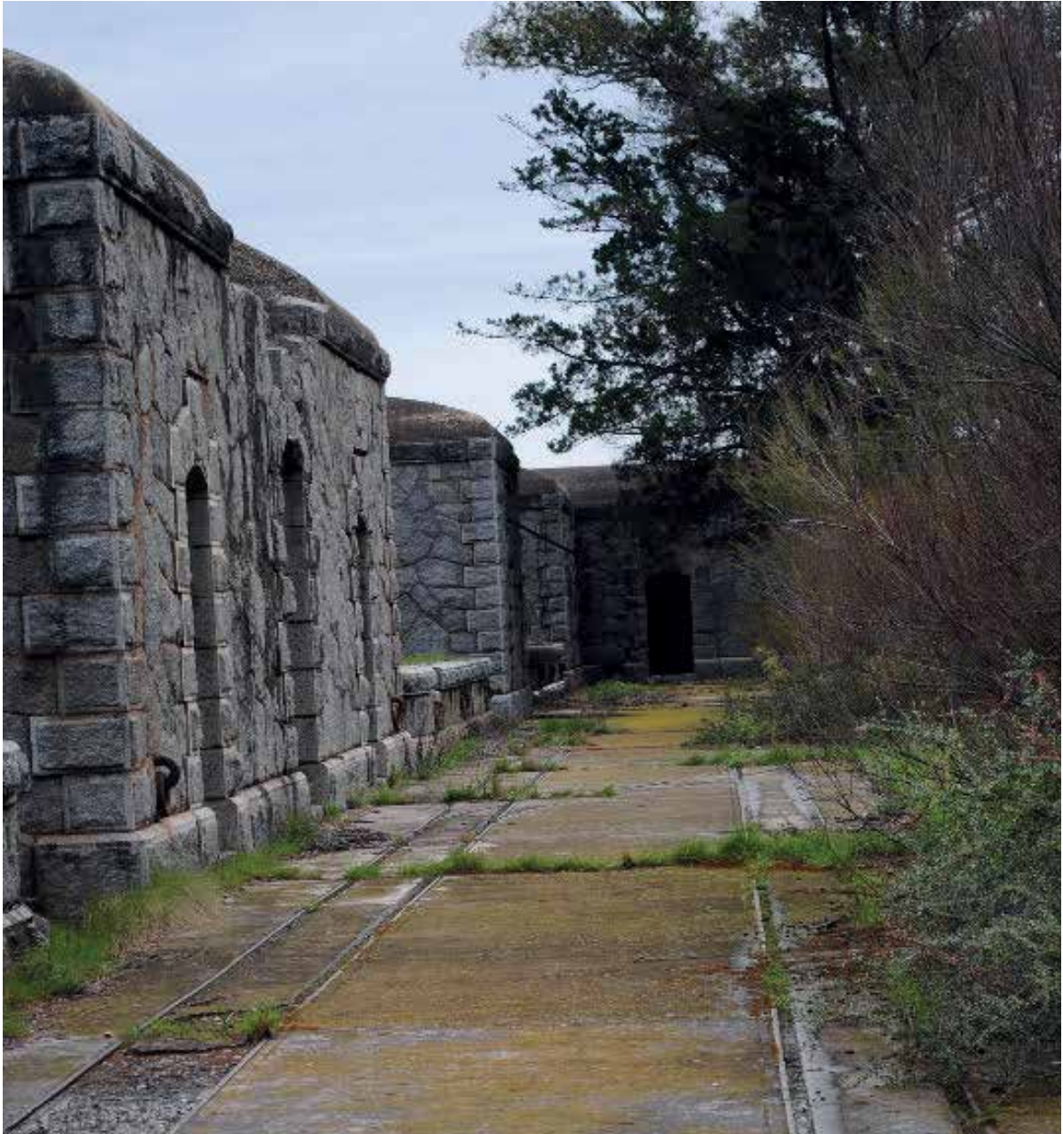
Baterías - Base naval. Punta Alta.
